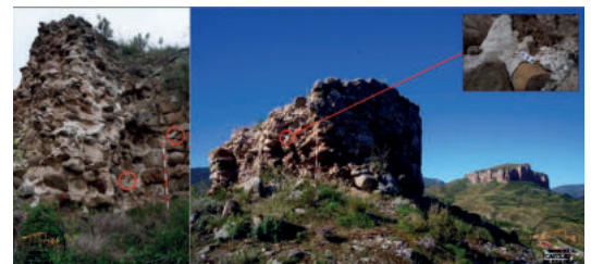
Fig. 1: Localización de la toma de muestras (C14) de carbones sobre yeso en el forro exterior y alma interna del cubo de defensa de la muralla de Peña Castillo, así como en el relleno constructivo de la torre de vigilancia y envío de señales de Peña Candil-Silla del Diablo, con el Castillo de Viguera-Valdemetria al fondo.
